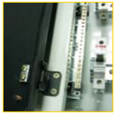
Earth Stud for Earth Cable
